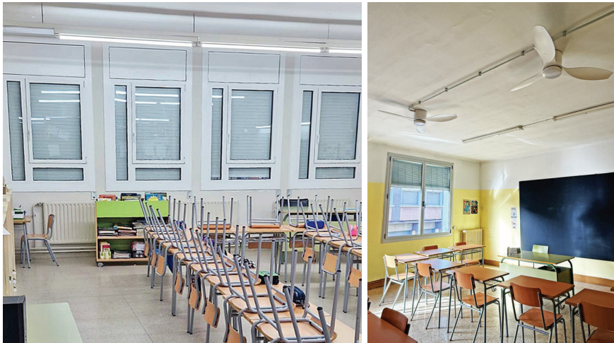
Els treballs han inclòs la renovació de finestres i la instal·lació de ventiladors. Les millores serviran per adaptar els centres al canvi climàtic i afavorir la gestió energètica.
