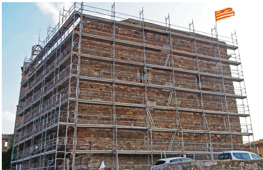
Les dues façanes del Castell, cobertes de bastides en l'inici dels treballs.
