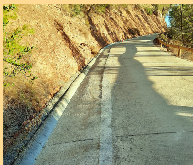
Tram arranjat del camí de Cererols.
