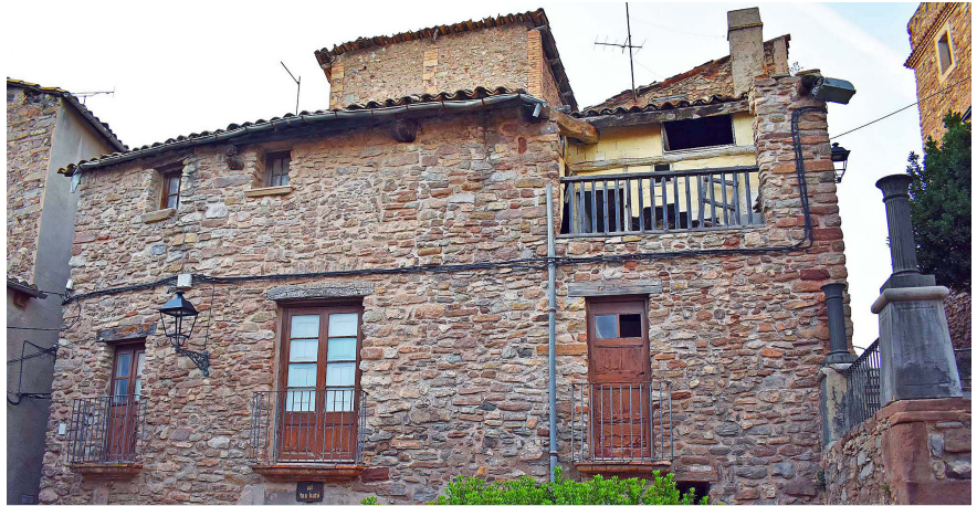
Edifici de Cal Ton Bató, que acollirà dos habitatges socials al Poble Vell
