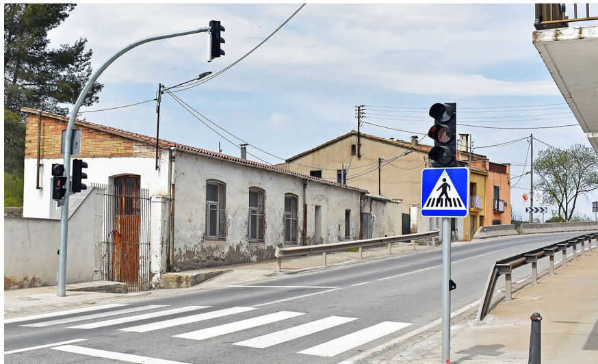
Un dels dos nous passos de vianants amb semàfor, instal·lats recentment
