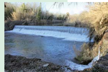
Resclosa al riu Cardener per a desviar l'aigua cap al canal curt del Fusteret.
