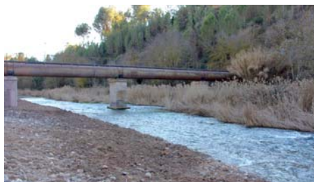
El riu Cardener i la canonada que portava l'aigua a la fàbrica del Fusteret per produir energia.
