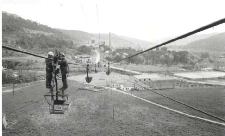
Dos operaris de la brigada de reparadors i conservadors del cable de Cabanasses. Arxiu ICL.
