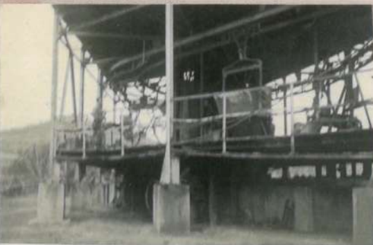
Imatge de l'estació d'Angle. El treballador que apareix és en Benjamí Merino. Arxiu Maria Merino.
