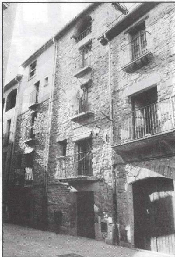
Detall de façanes de la Plaça
