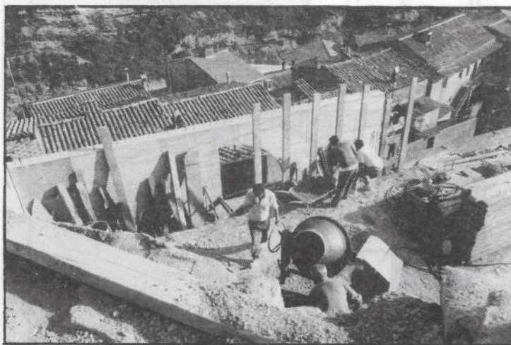
Obres de restauració, tercera fase
