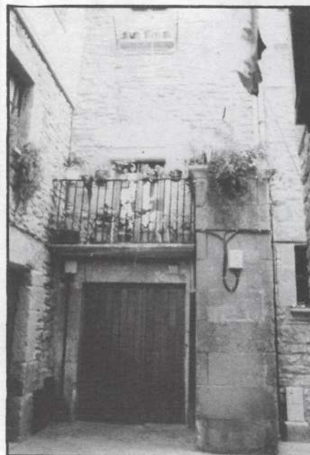
Cisterna de Cal Xicana. Carrer de Sant Climent
