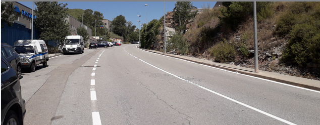
ABANS DE LES OBRES
