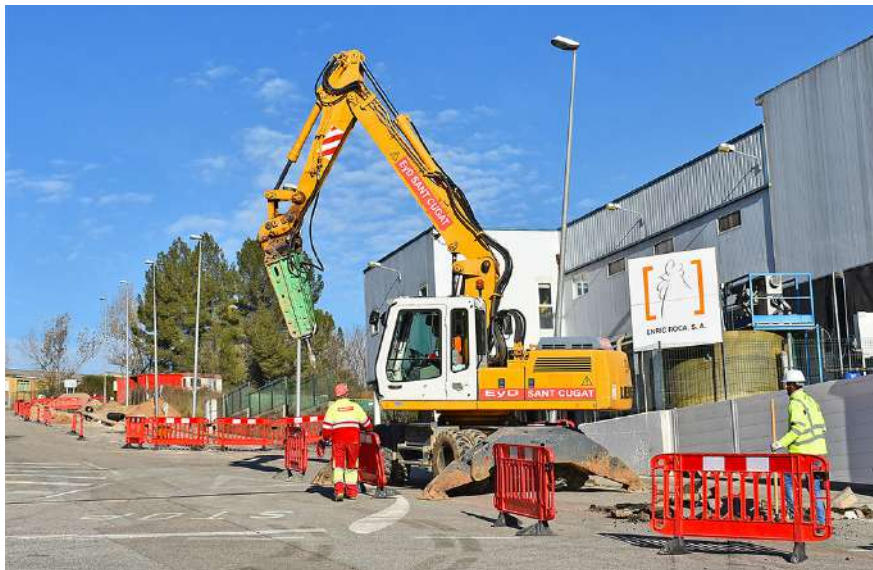
Inici de les obres que es desenvolupen al vial principal de La Pobla Nord
