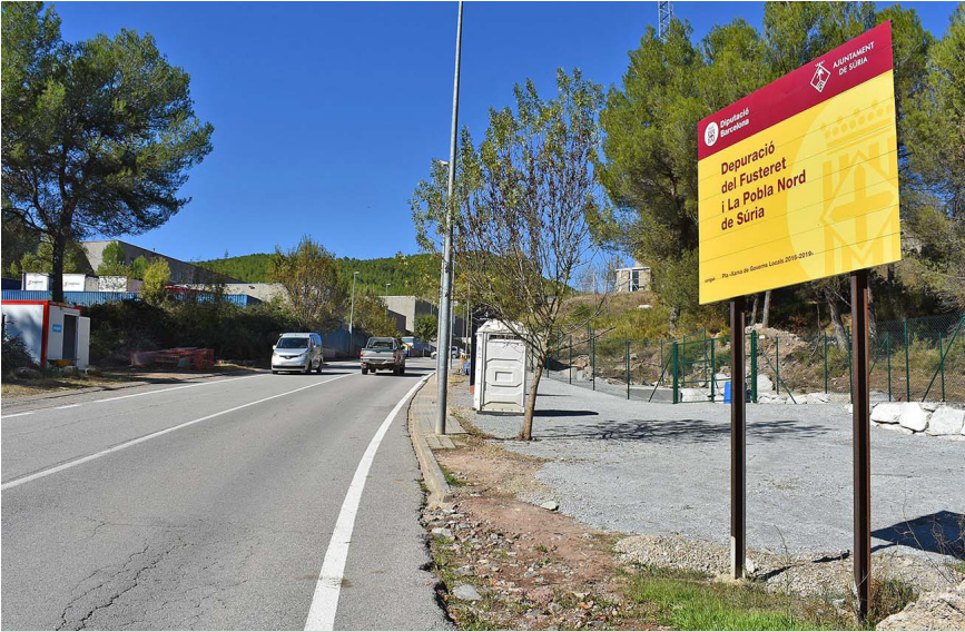
Cartell de les obres d'ampliació de la depuradora al polígon La Pobla Nord
