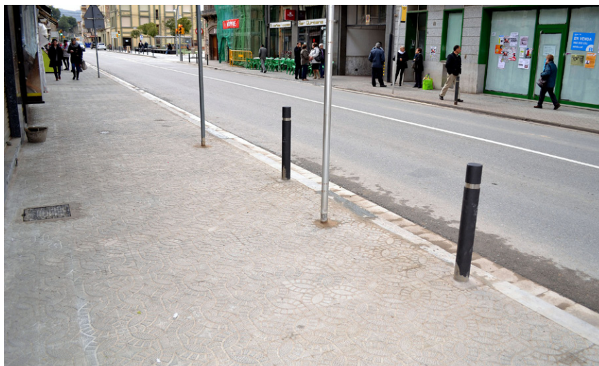
Imatge d'una part del carrer González Solesio, després de la repavimentació L'actuació ha estat finançada íntegrament pel Pla Xarxa de la Diputació de Barcelona
