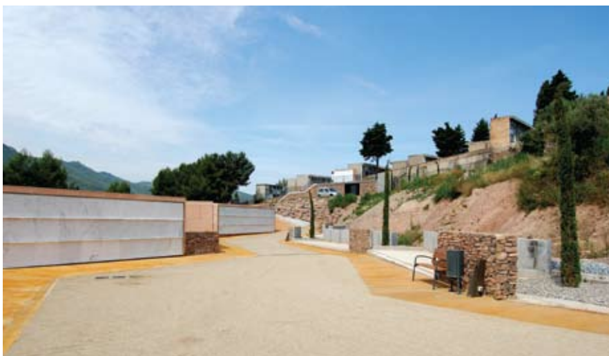
La capacitat del recinte s'ha adaptat a les previsions futures Les obres han servit per millorar les condicions d'accés al recinte
