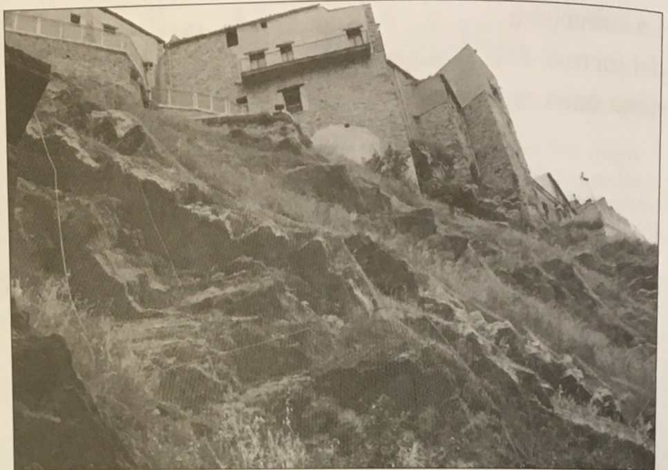
Una malla protectora ha acabat amb els desprendiments de roques al barri de Sant Jaume.
