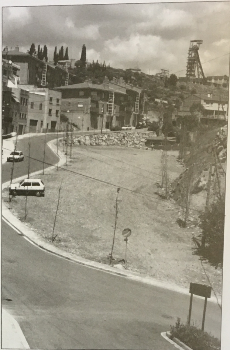
L'entorn del Poble Vell ha recuperat espais que podran destinar-se a zona verda i aparcaments.
