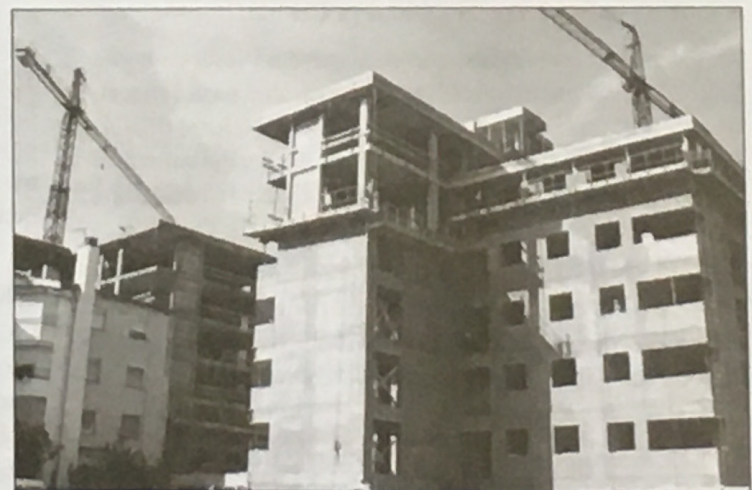
La segona fase d'obres per a la substitució dels habitatges amb aluminosi de Salipota, va avançant.
