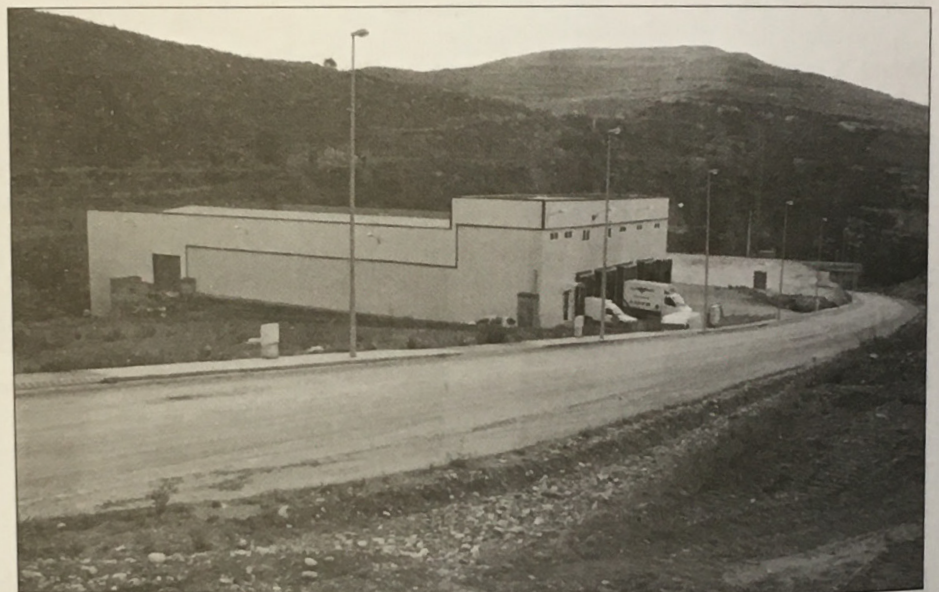
Vial del polígon industrial de La Pobla. Al darrere de la primera nau, ja es comença a esplanar per edificar-hi noves indústries.
