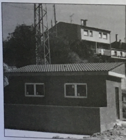
L'abastament d'aigua del Poble Vell, Bellavista i Santa Maria, ha estat reforçat amb aquesta estació instal·lada al torrent dels Galàpets.
