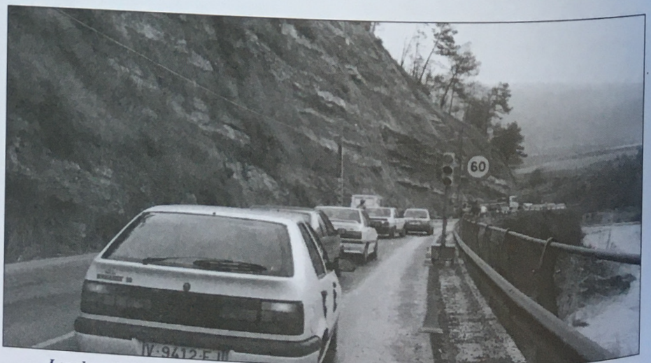
Les obres de protecció del balç del Lladó, a la carretera C-1410, van realitzar-se durant el 1996
