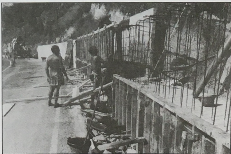
Carreteres ha executat una important obra de protecció al tallat de roques del balç del Lladó.
