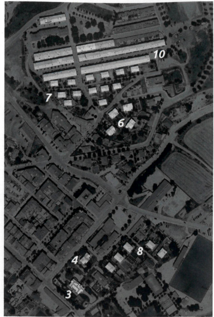
Figura 1: La “ciutat obrera” de la Solvay a Síria, amb els diferents tipus d'habitatges (1918-1926).
