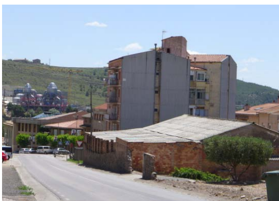
Carretera de Castelladral. Àmbit de la UA-13.
