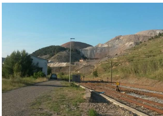
Via del ferrocarril entre la mina i nucli d'El Fusteret.
