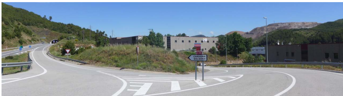
SAU-2 La Poble Nord. Accés a la carretera C-55.
