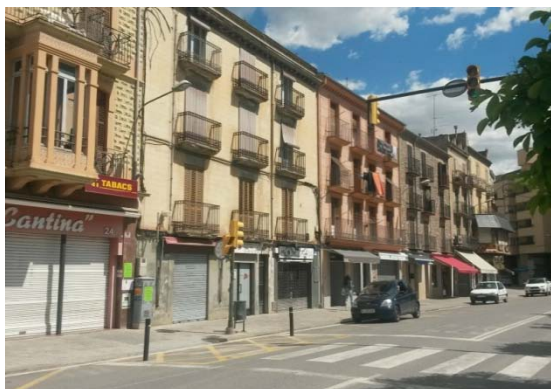
Façana comercial de l'eix de l'antiga carretera.
