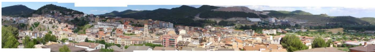
Vista de Súria des de l'esplanada de maniobres per a la construcció del túnel de la carretera C-55.
