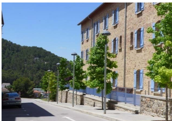
Carrer de Mare de Déu del Pilar. Residencia Ampans.
